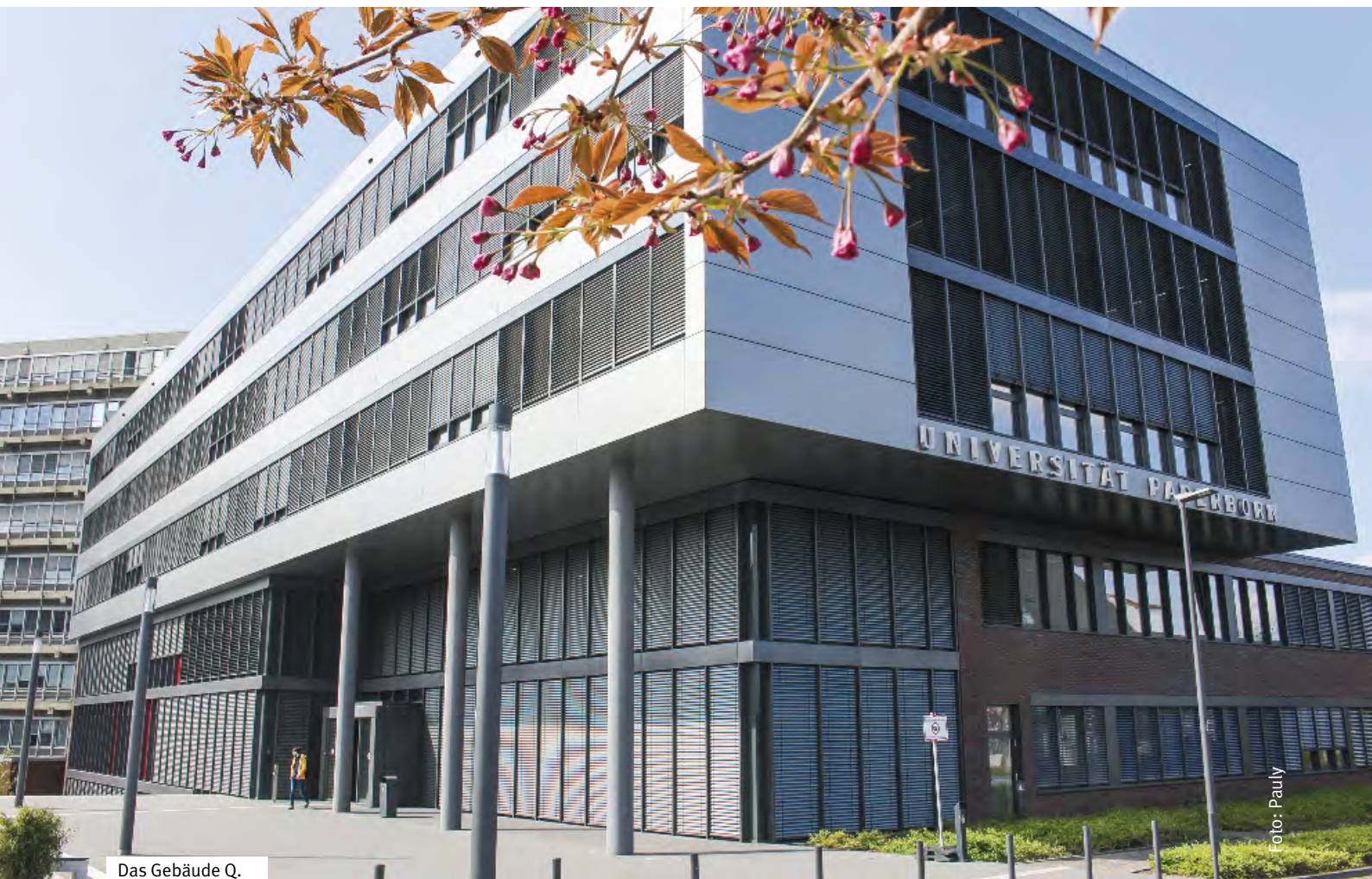
Das Gebäude Q.
